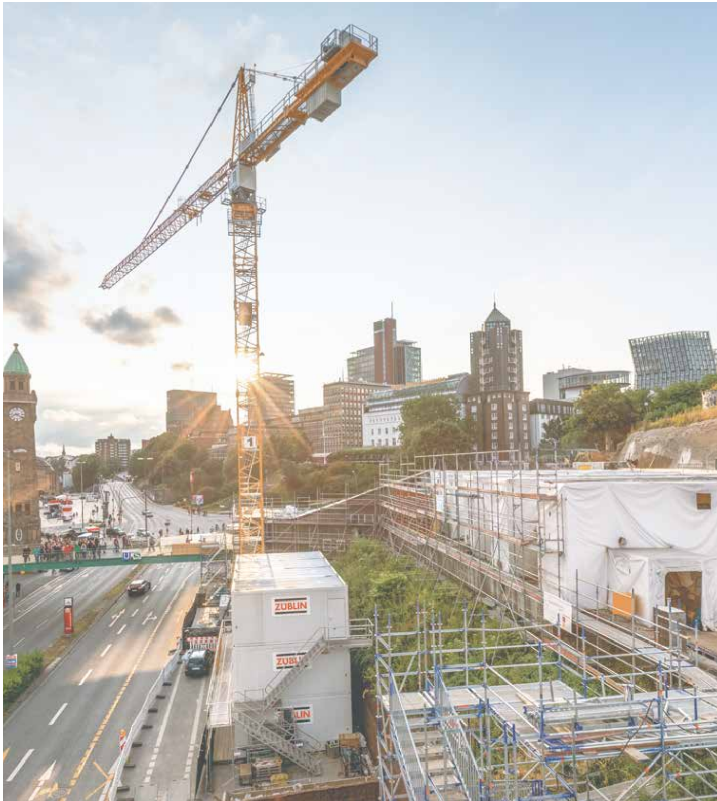
Großbaustelle Landungsbrücken: Die U3-Haltestelle während der Sanierungs- und Umbauphase.
