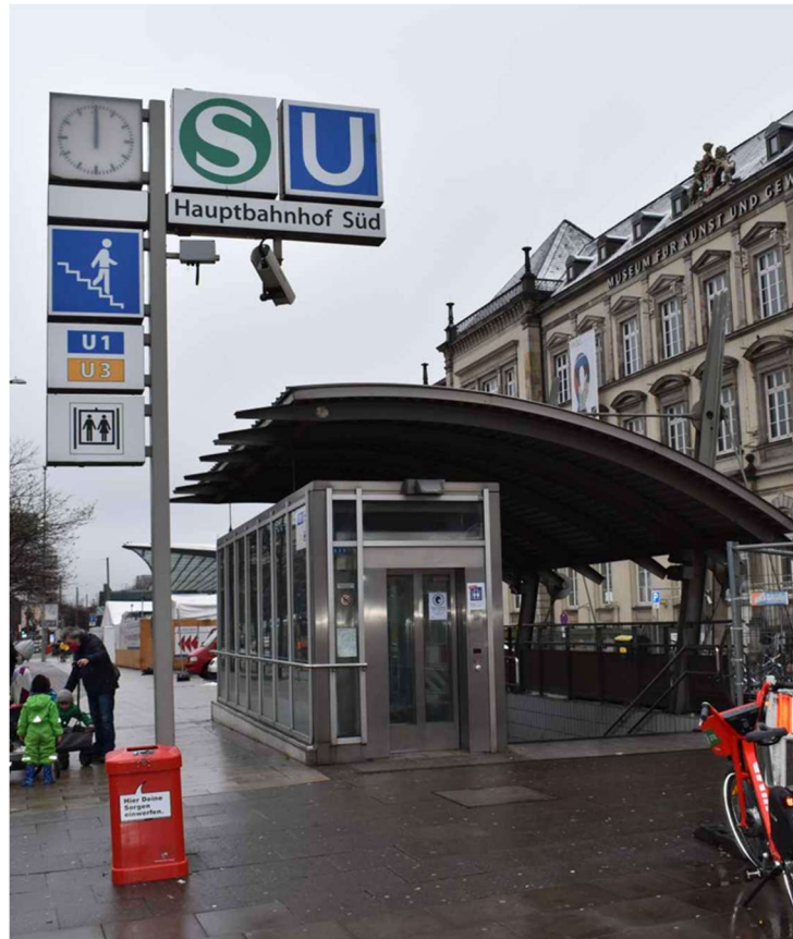
Abbildung 1: Zugang Halle D (Steintordamm)
